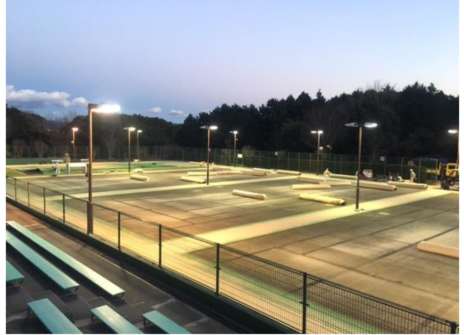
1～4コート改修工事中
